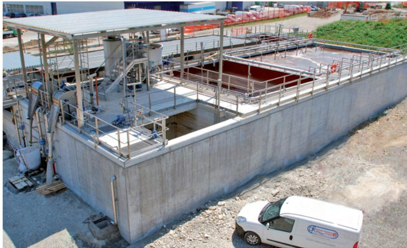
Wasseraufbereitungsanlage mit mechanischen Filtersektionen, chemisch-physikalischem Stadium und biologischer Sektion zur Beseitigung organisch gelöster Rückstände
